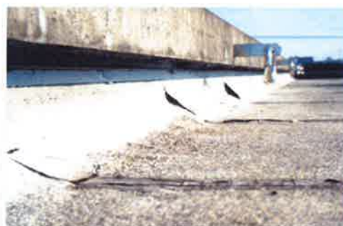
立上防水材の破断
