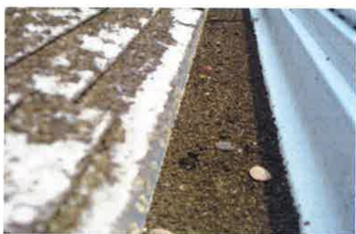
砂粒子の劣化により軒桶に砂がたまる
