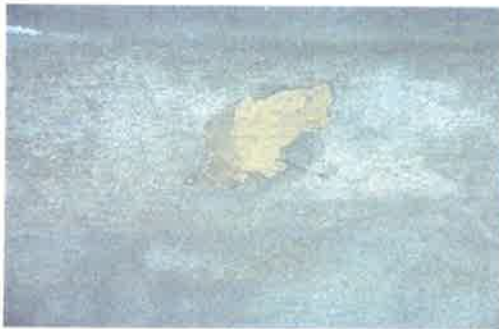
塗膜の欠損
